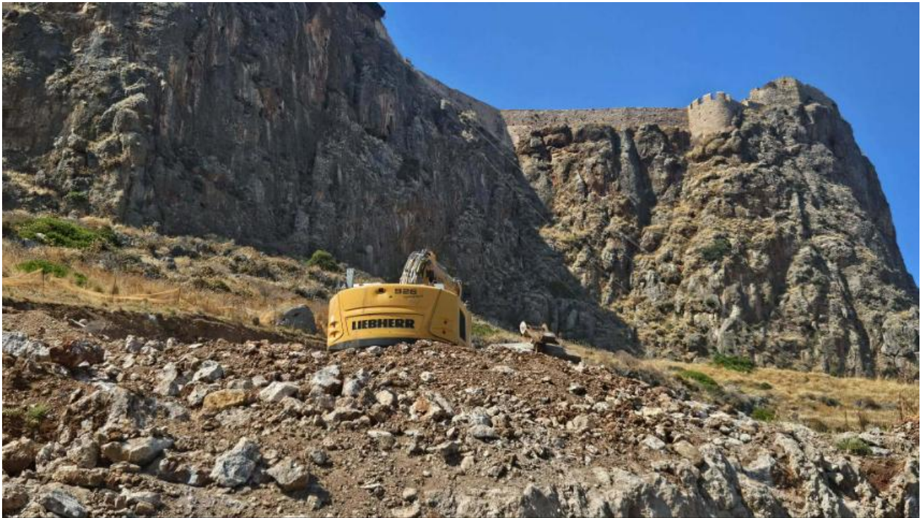
Εικ. 3: Θέση εκτέλεσης του έργου. Από τη φωτογραφία είναι εμφανές ότι στο σύνολο της θέσης δεν υφίστανται βραχομηχανικές στερεώσεις ή μέσα συγκράτησης κατάπτωσης βράχων.
