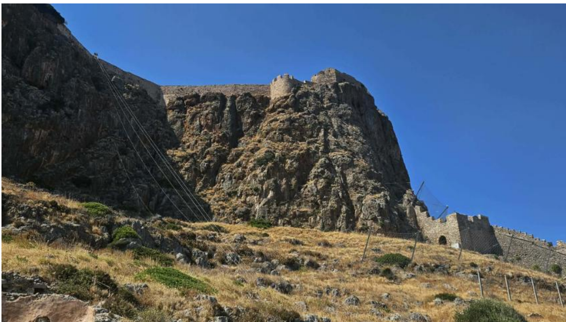
Εικ. 3: Θέση εκτέλεσης του έργου. Από τη φωτογραφία είναι εμφανές ότι στο σύνολο της θέσης δεν υφίστανται βραχομηχανικές στερεώσεις ή μέσα συγκράτησης κατάπτωσης βράχων.
