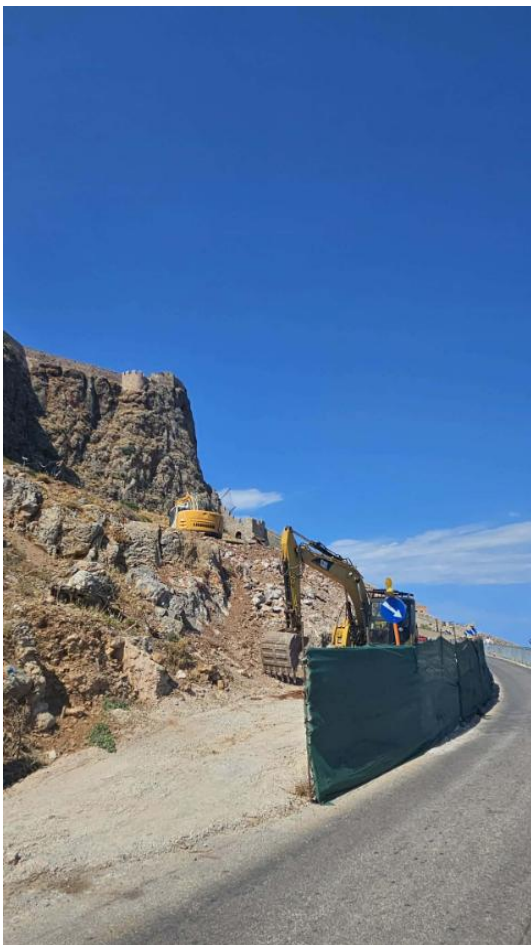
Εικ. 11 & 12: Άποψη του έργου από το επίπεδο του δρόμου. Έχει απομείνει μια λωρίδα κυκλοφορίας για τα διερχόμενα οχήματα. Η διάβαση των πεζών πραγματοποιείται στο άκρο του δρόμου και για την ασφάλεια αυτών έχουν τοποθετηθεί μεταλλικά εμπόδια.
