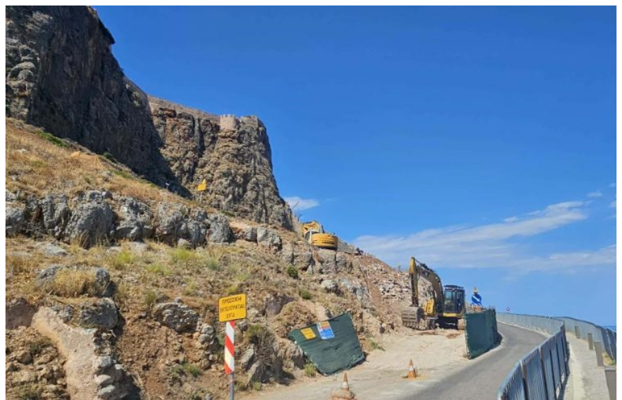
Εικ. 11 & 12: Άποψη του έργου από το επίπεδο του δρόμου. Έχει απομείνει μια λωρίδα κυκλοφορίας για τα διερχόμενα οχήματα. Η διάβαση των πεζών πραγματοποιείται στο άκρο του δρόμου και για την ασφάλεια αυτών έχουν τοποθετηθεί μεταλλικά εμπόδια.
