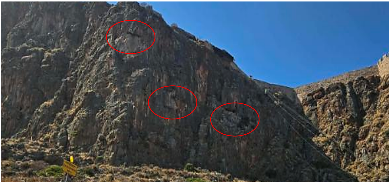
Εικ. 6, 7, 8: Ρηγματωμένος/ διαβρωμένος βράχος σε διάφορες θέσεις στην έκταση εκτέλεσης του έργου. Μη συμπαγές ασβεστολιθικό υπόβαθρο.
