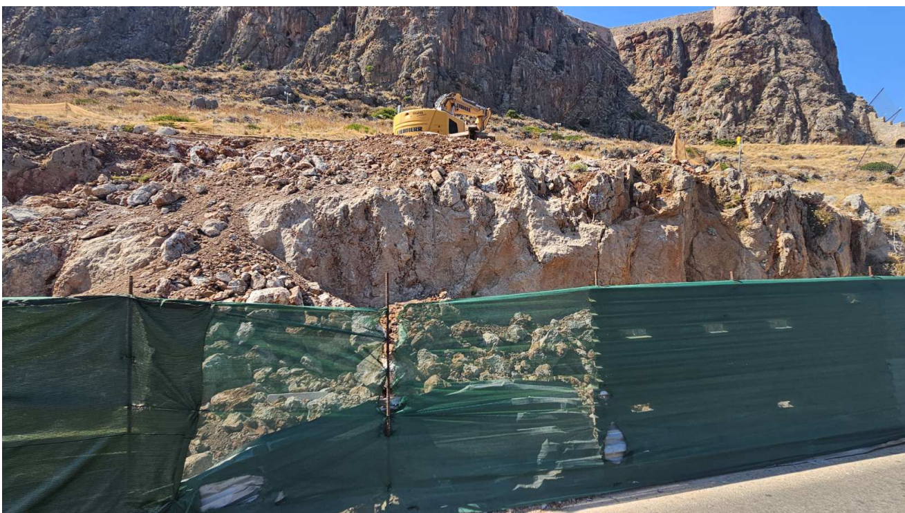
Εικ. 9: Εκτέλεση του έργου σε δύο επίπεδα. Εμφανείς εκβραχισμοί στο 1 ο επίπεδο.
