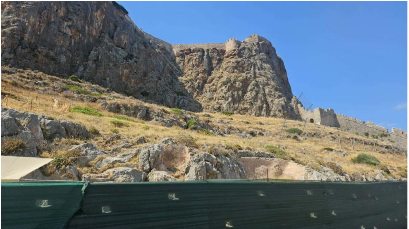
Εικ. 10: Αποκάλυψη αρχαίων δεξαμενών στο 1 ο επίπεδο του έργου.
