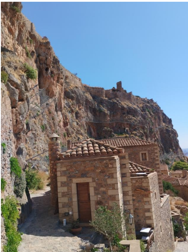
Εικ. 1 & 2: Μεταλλικά πλέγματα συγκράτησης κατάπτωσης βράχων και πλέγματα βραχομηχανικών στερεώσεων στην Άνω Πόλη του παραδοσιακού οικισμού Μονεμβάσις
